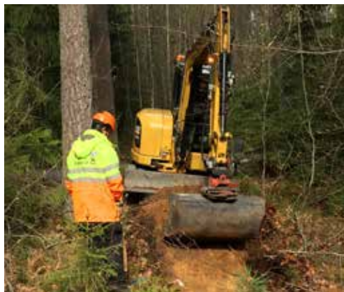
Figur 3. Pågående sökschaktning. Foto Simon Säfström, Sweco.
