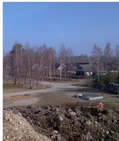
Vi bygger om Allmogevägen och ansluter den till gatorna i Vikaholm.
